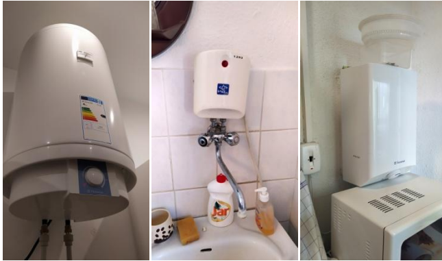
Obrázok 9. Elektrické zásobníkové ohrievače
