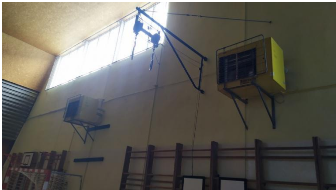
Obrázok 18. Plynové ohrievače vzduchu
